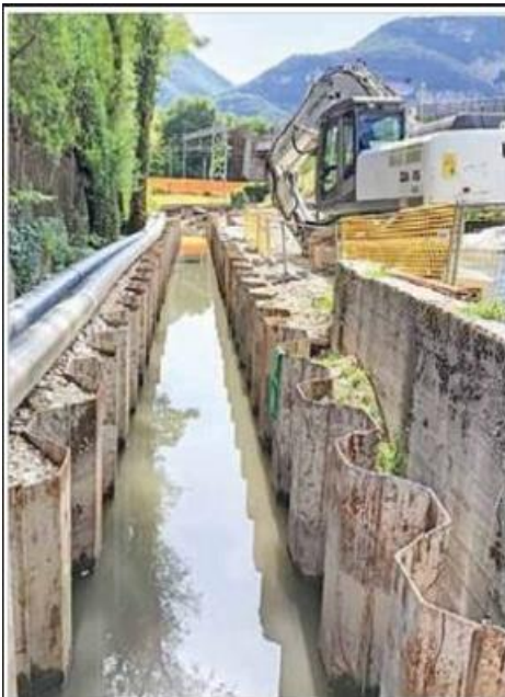
Il Lavisotto e il cantiere per la bonifica
