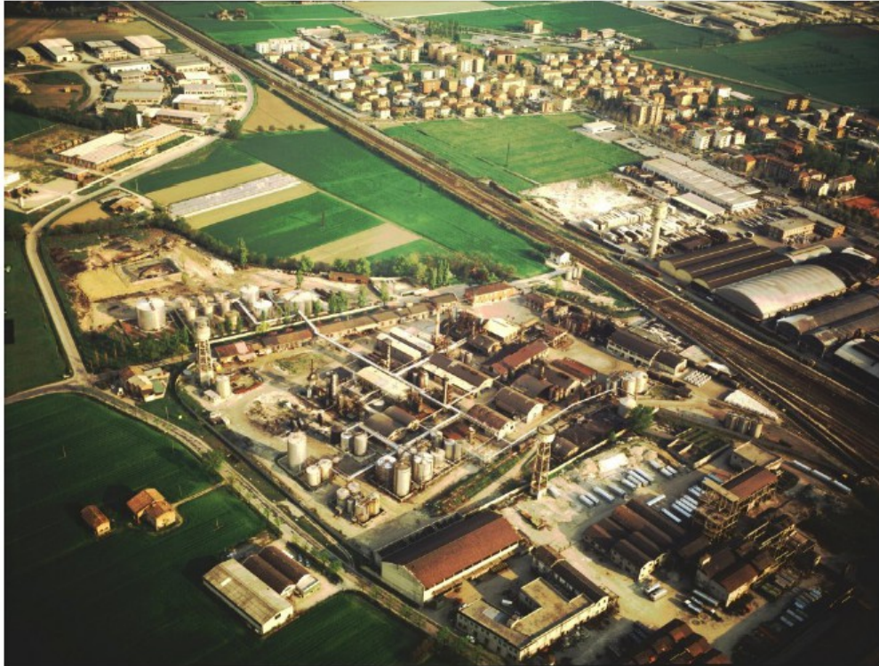
aree ex Carbochimica ed ex Cip (veduta aerea stabilimenti negli anni '80)
